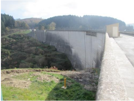
Barrage des CAMMAZES
